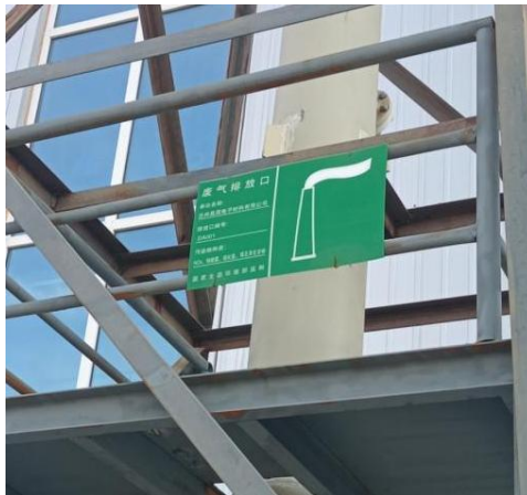
废气排放口标志
